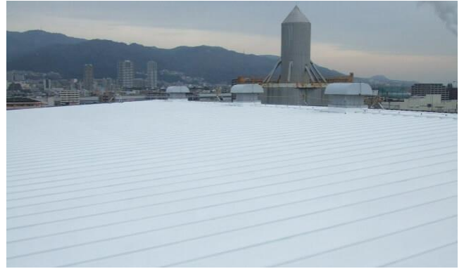
▲ 防水塗料の塗布完了
